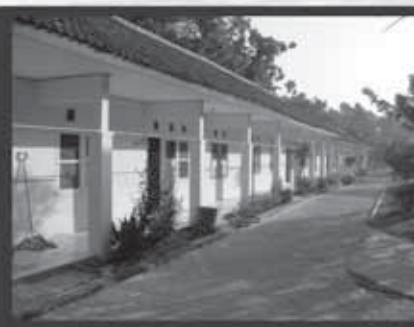
Bangunan asrama putra yang telah selesai di renovasinya
